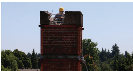
Удаление кирпичной отопительной трубы.
