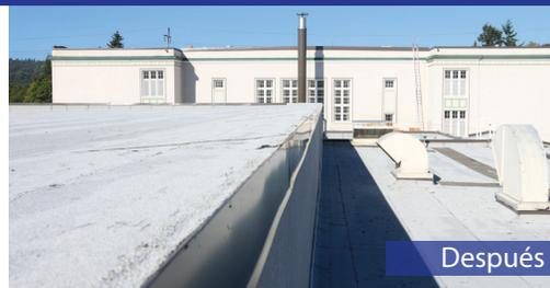
Renovación del techo, incluyendo: mejoras sísmicas e instalación de nuevos materiales aislantes, instalaciones mecánicas, escaleras y tejado.
