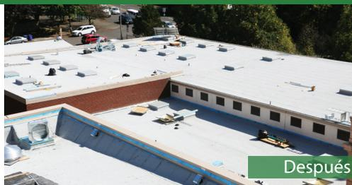
Renovación del techo, incluyendo: mejoras sísmicas e instalación de nuevos materiales aislantes, instalaciones mecánicas, escaleras, tejado y, tijerales metálicos en el piso superior del gimnasio.
