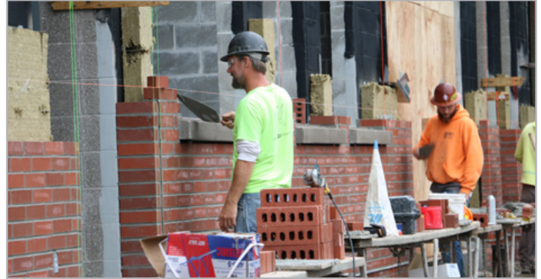
砖砌建筑工作
