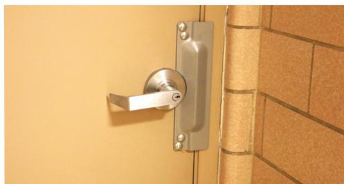
Modificación de algunos baños para hacerlos asequibles a todos. Instalación de ferretería y perillas de puertas en toda la edificación, conforme a las directrices ADA
